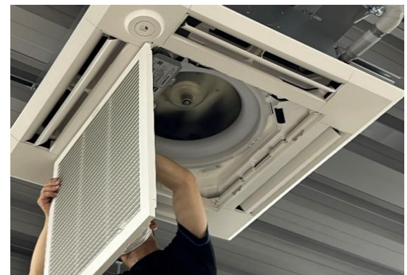
エアコンフィルターの定期清掃の様子
